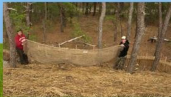
Red de yute y grapas que se usa para detener la pérdida de suelo en una pendiente.
