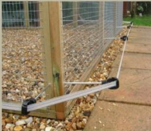
Una línea de alambre eléctrico alrededor de las cercas ayuda a controlar varios depredadores
